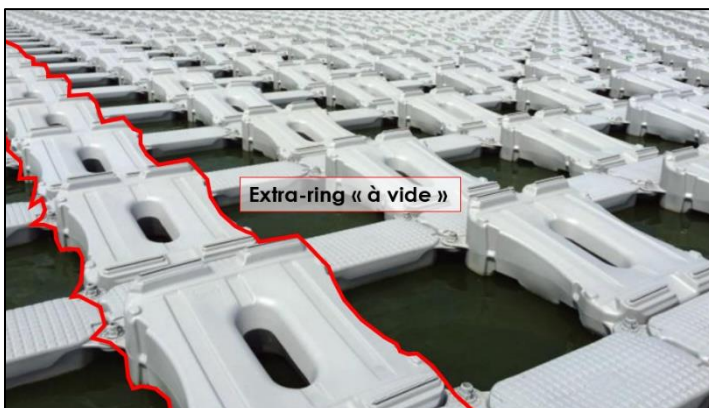
(Ci-dessus) Figure 5 : Position des rangées de flotteurs supplémentaires.
