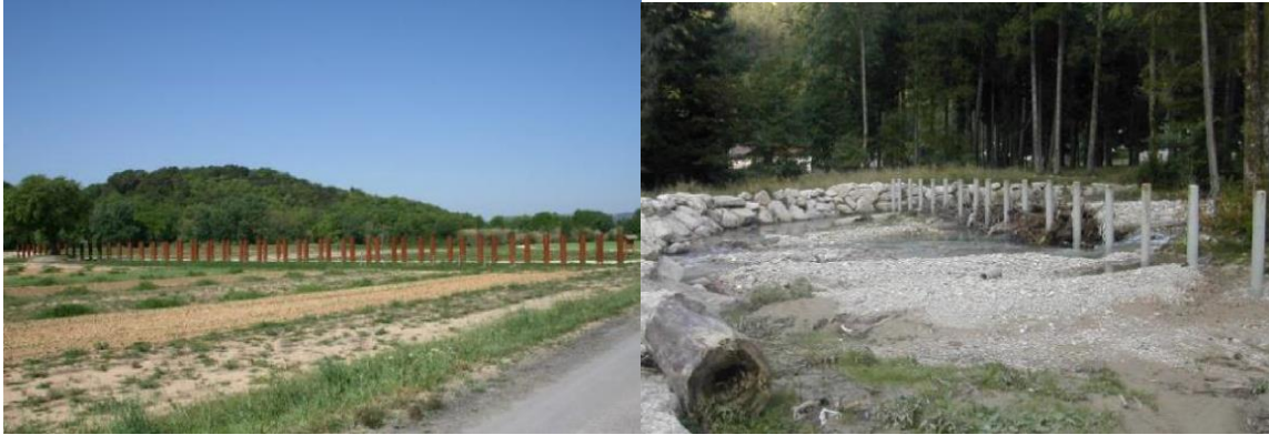
Figure 5 : Exemple de pieux métalliques dans un champ (gauche) et de peignes en lit mineur (droite)
