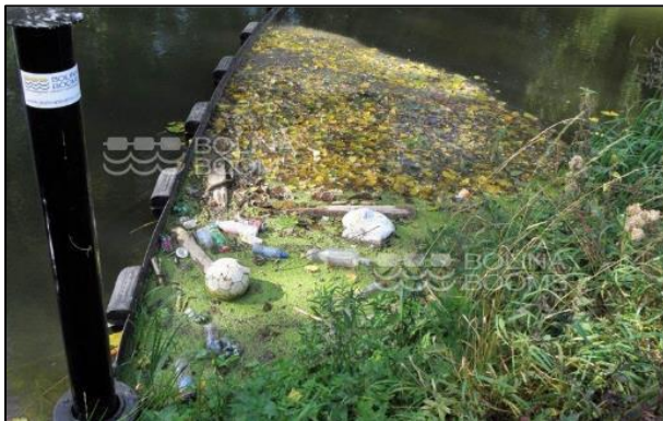
Figure 3 : Exemple de drômes pour le piège des flottants
